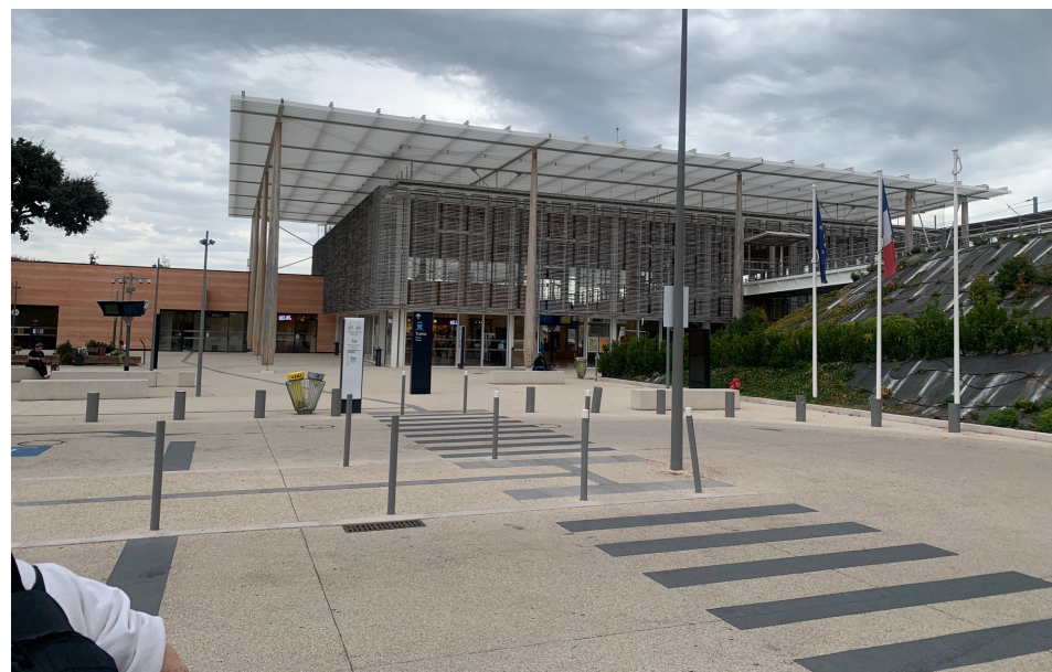
Pont du Gard TGV station
